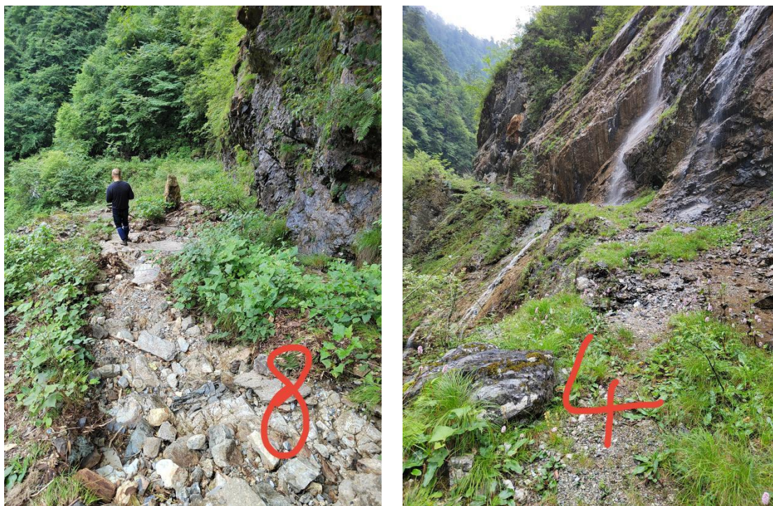
图 2.8-4 铅厂沟道路现状
