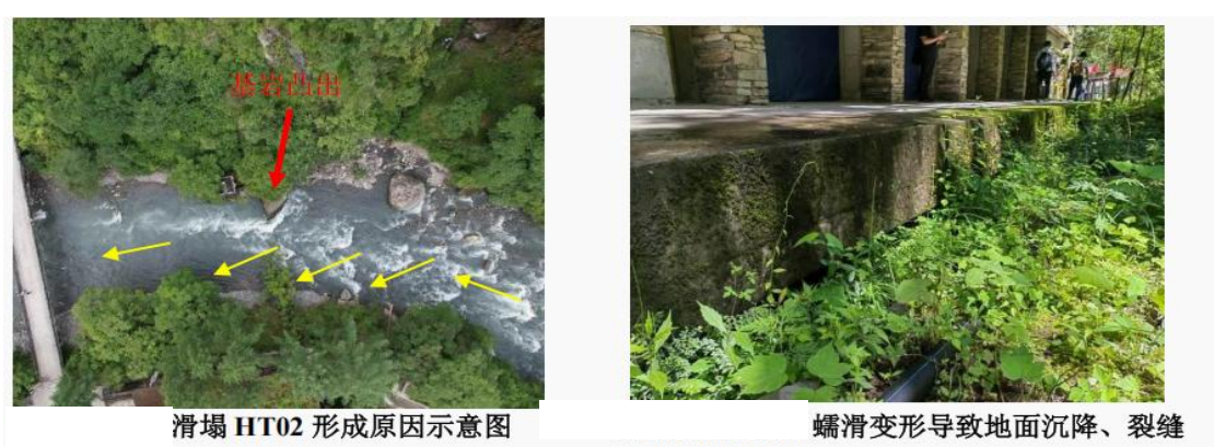
图 2-1-6 洪水侵蚀岸坡地面开裂垮塌前后
