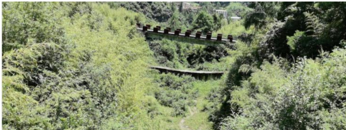
图 2-1-16 李家沟泥石流已建拦挡坝
