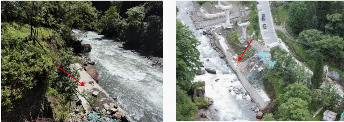
图 2-1-15 都四工程护岸挡墙照
