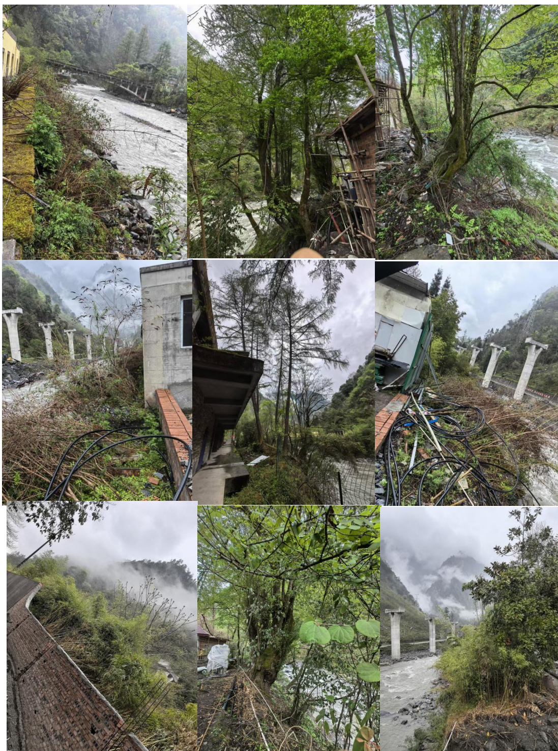
图 2-2-10 河岸与现有建筑关系（岸线空间十分狭窄）
