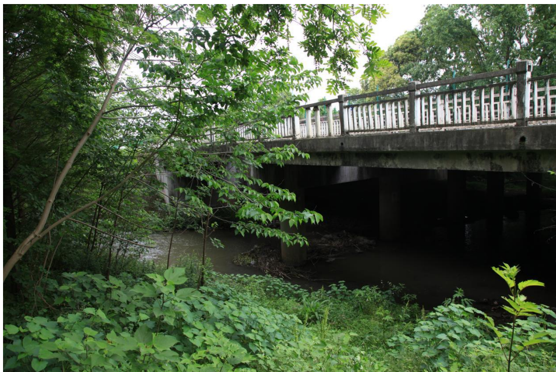
高速及辅道跨桤木河道群众桥现状
