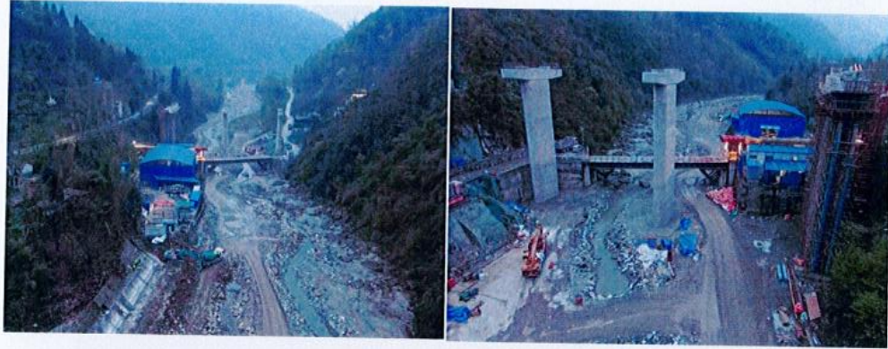
“都江堰至四姑娘山山地轨道交通扶贫项目”在白沙河河道 修建桥墩照片
