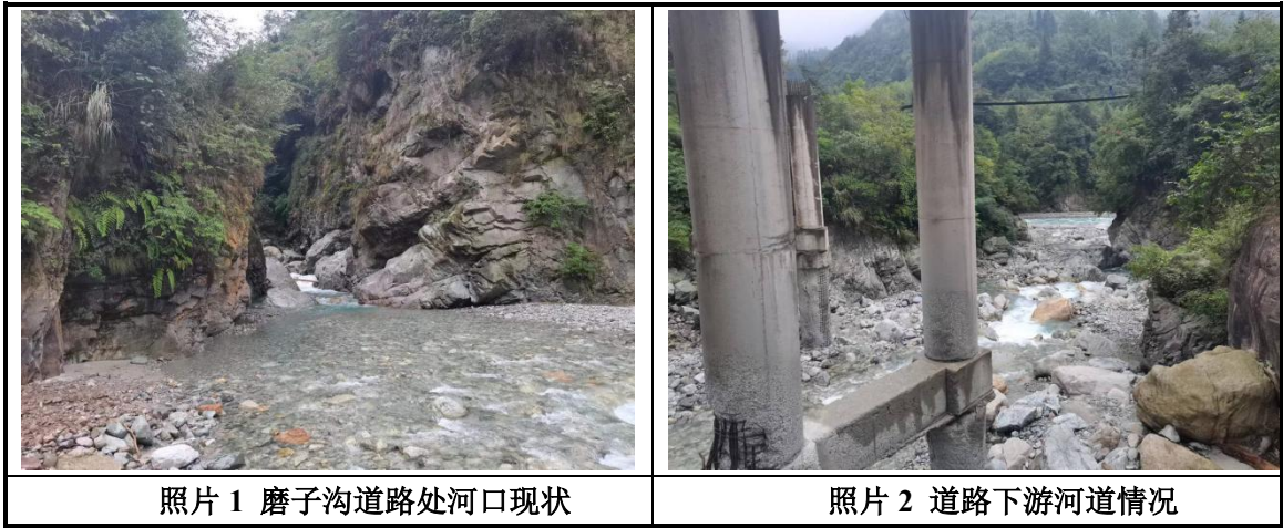
图 4-2 磨子沟河口及河口下游现场照片
