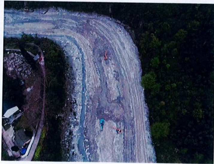
白沙河小流域河道治理机具作业照片
