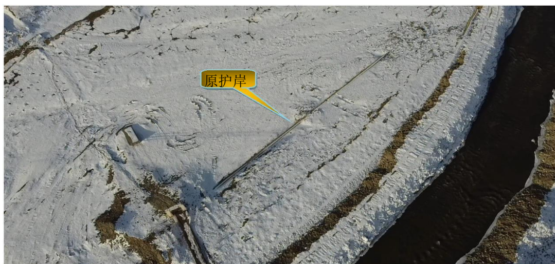
图 2-3 岸坡原护岸和临时堆砌现状
