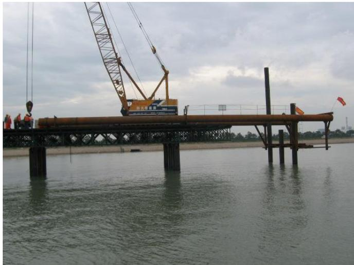
图 2-6 “钓鱼法”施工栈桥照片
