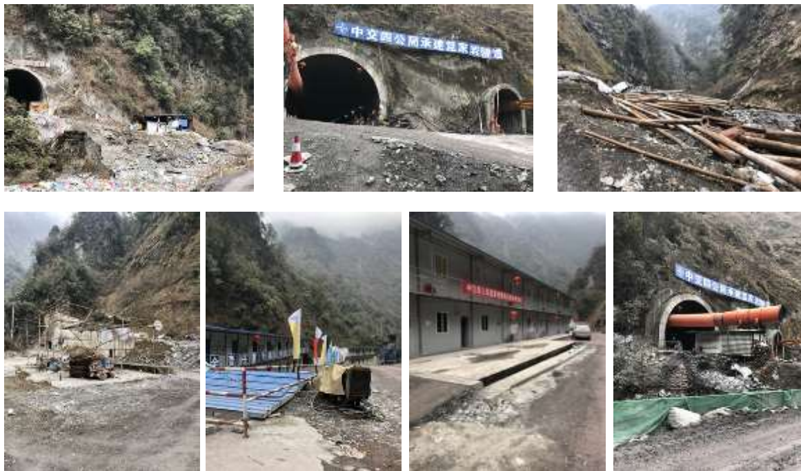
现场照片： 蓝家岩隧道口及周边临时施工场地
