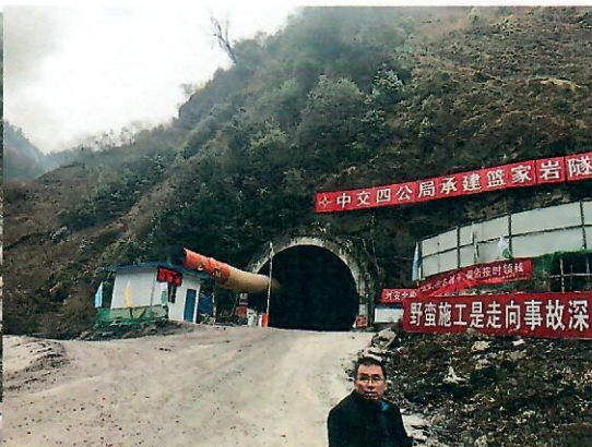
图 4 蓝家岩隧道已经进行了施工
