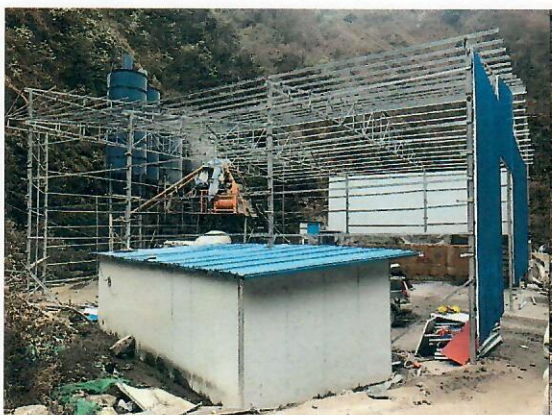
图 5 临时施工厂房
