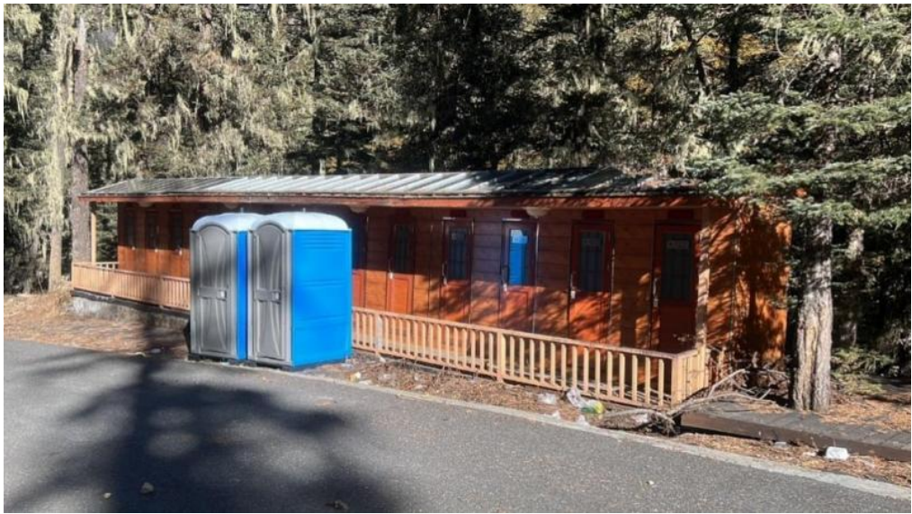
图 3—6—1 盐水沟沟口旅游公厕现状照片
