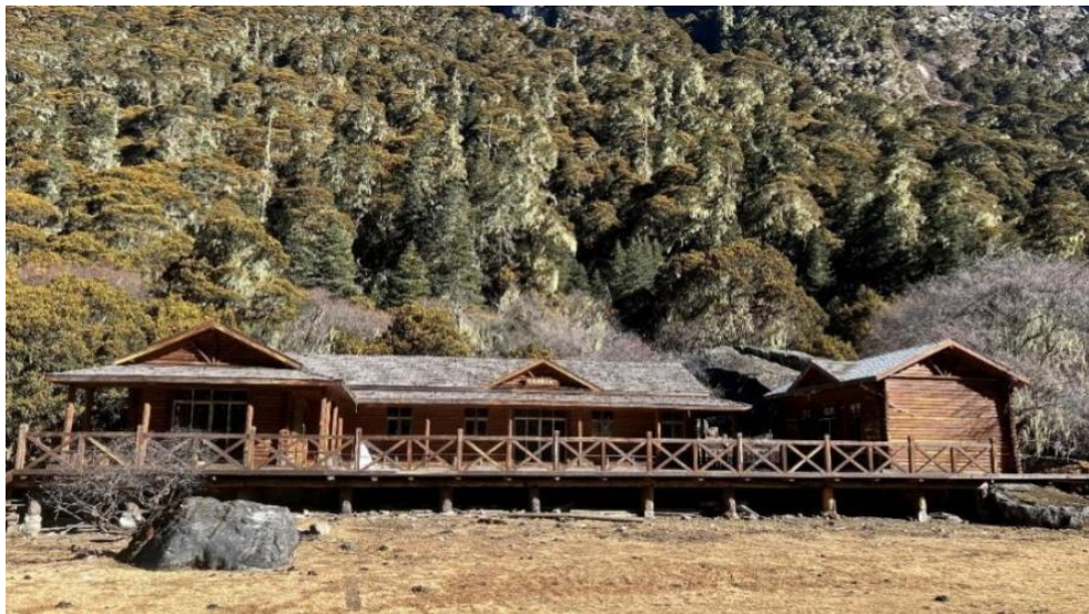
图 3—6—2 猎塔湖景区展厅（若珠）现状照片
