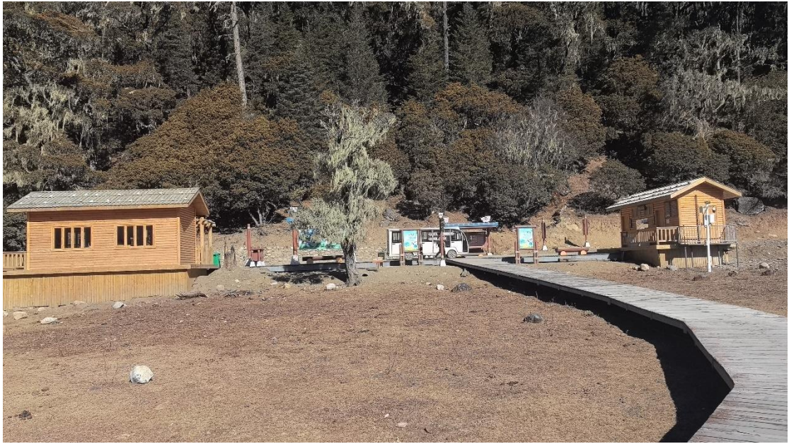
图 2—6—3 伍须海下草甸木质观景栈道现状照片
