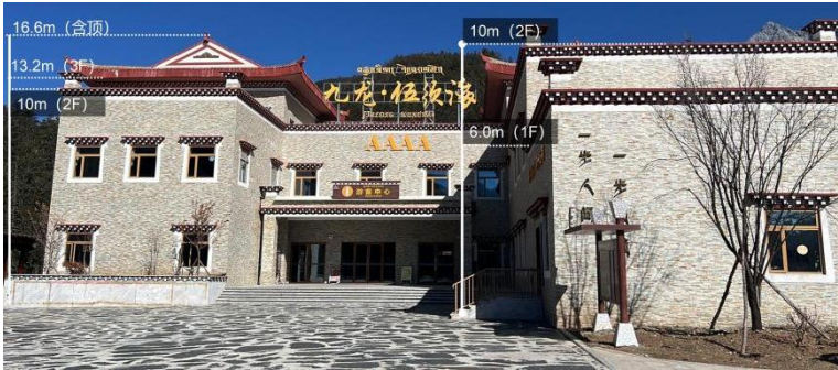
图 3 建筑高度及退台设计示意
