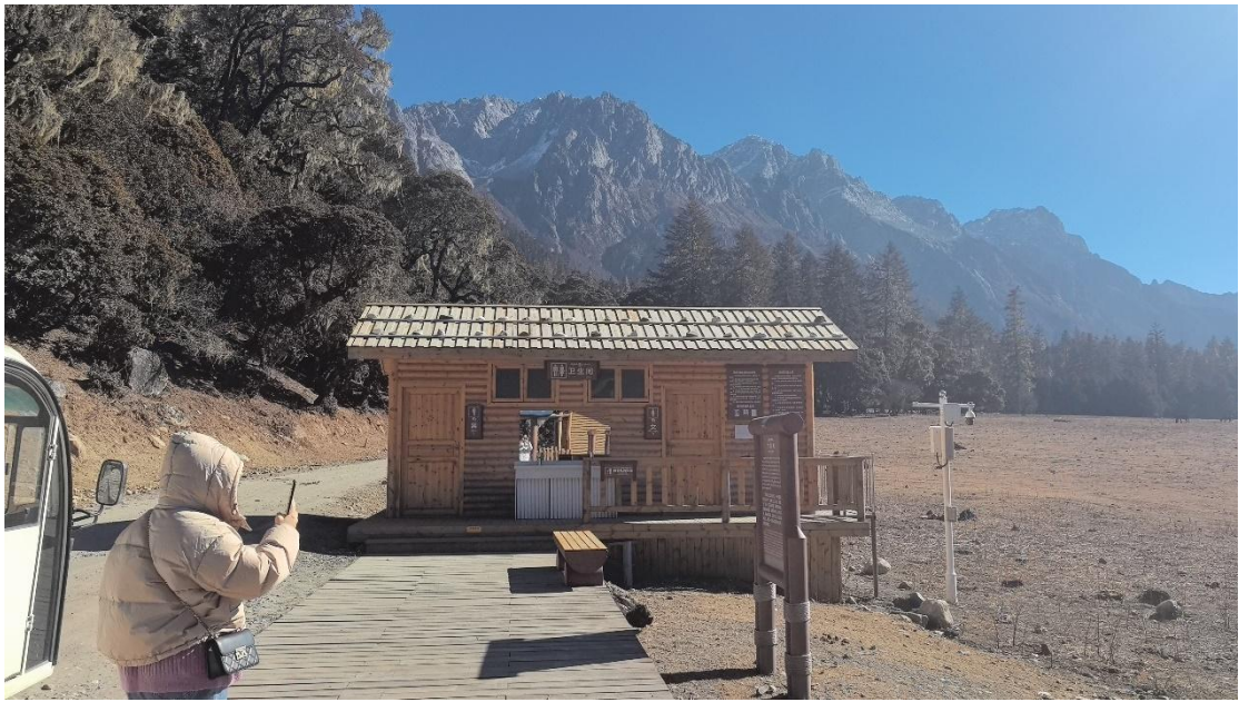
图 2—6—8 下草甸—3A 厕所 1 现状照片
