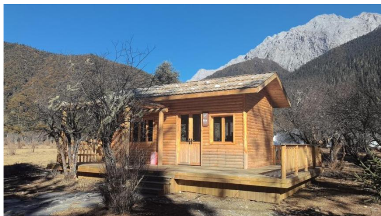
图 2—1—15 下草甸—吸氧室 2 照片
