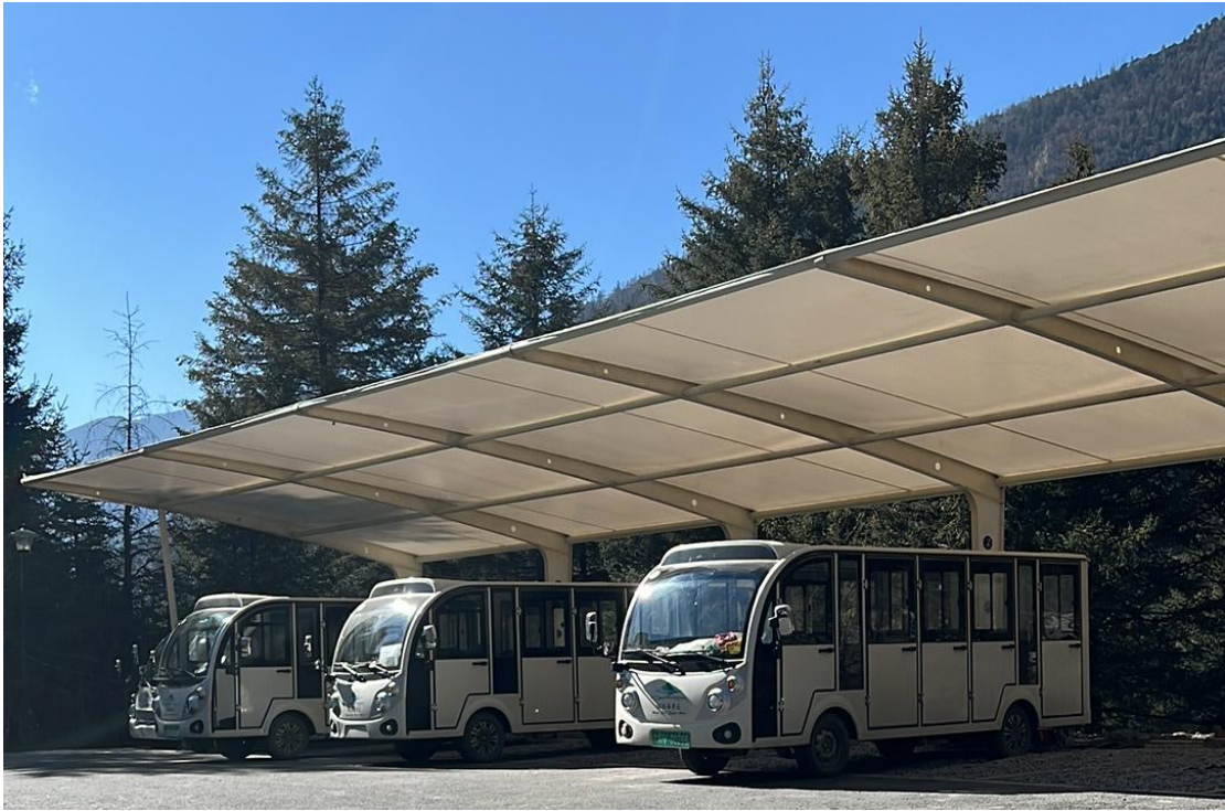
图 2—6—5 伍须海电瓶车转运中心现状照片
