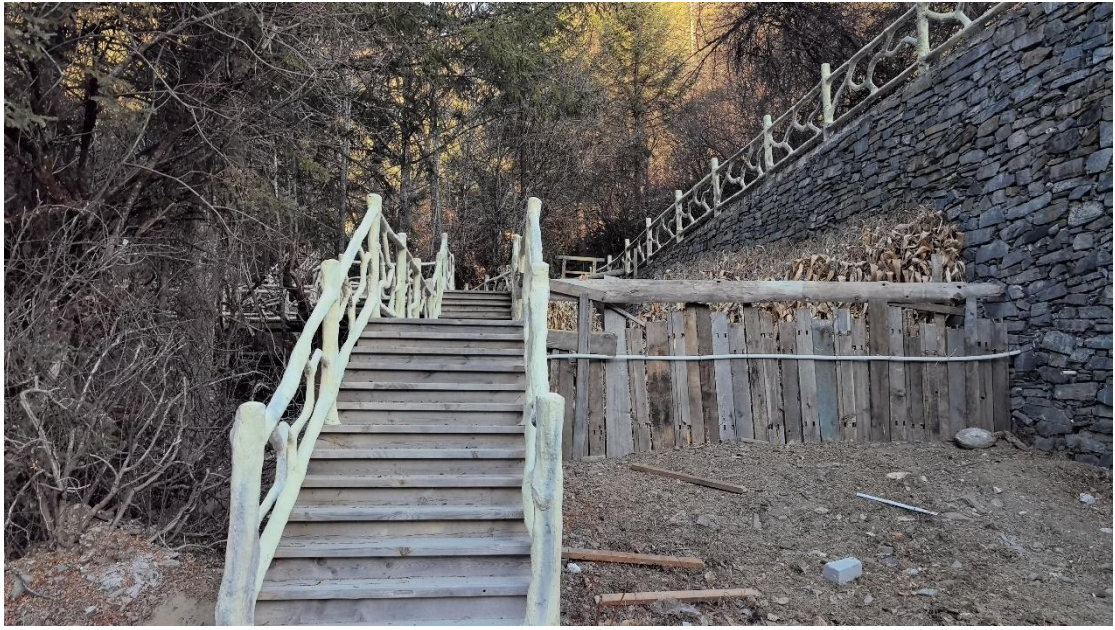
图 2—6—1 伍须下村—栈道现状照片
