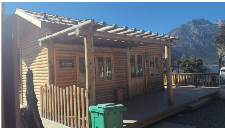
图 2—1—14 下草甸—吸氧室 1 照片
